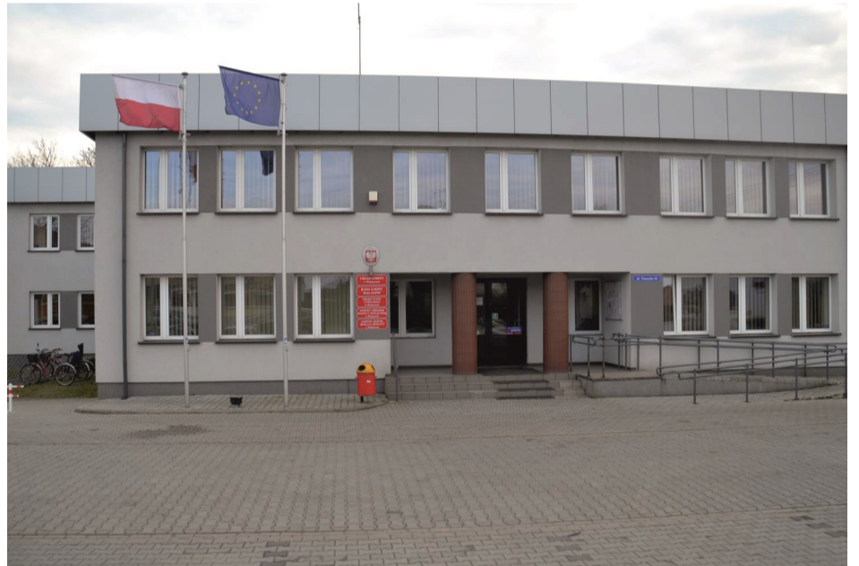
Budynek urzędu po remoncie w 2011 r.
